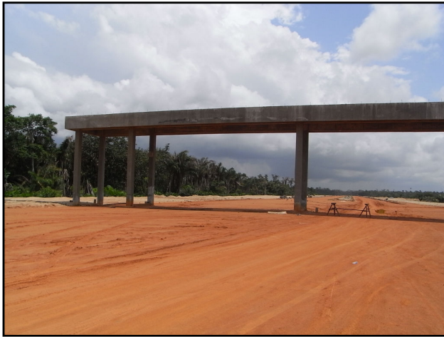
図 41 工事が中断している Lekki 自由貿易地区の様子。
